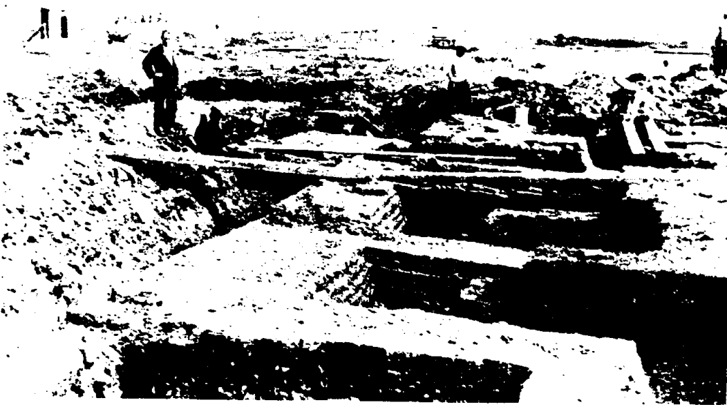
In den z.g. Spaanschen polder nabij de Delfsharensche Schie is de speciale opgravingsploeg van de Divero begonnen met opgravingen naar het kasteel Spangen, dat in 1572 door de Spanjaarden werd verwoest. Een groot gedeelte der fundamenten van het kasteel is reeds blootgelegd. (Foto Polygoon-Hof)
