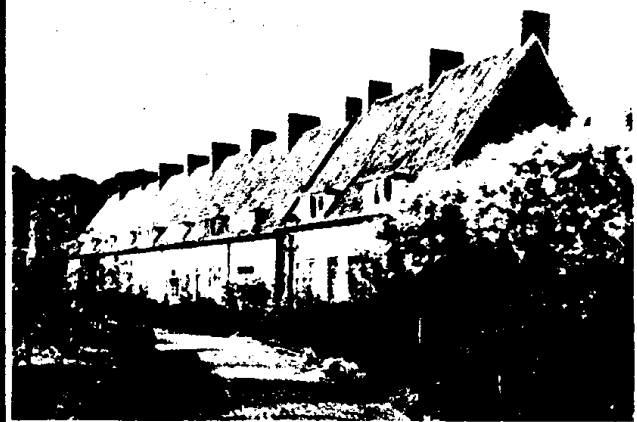
Granpré Molière, Verhagen en Kok. — Tuindorp Vreewijk, Rotterdam. Een straatje uit een der fraaiste tuindorpen van ons land. Groot gehouden eenvoudige hoofdvormen.
